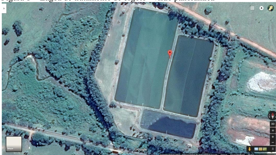
Figura 1 - Lagoa de tratamento de esgoto - visão panorâmica
