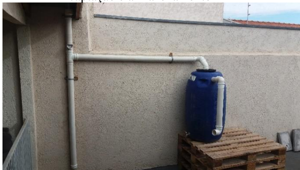
Figura 18 – Sistema de filtragem, descarte inicial, captação e armazenamento
