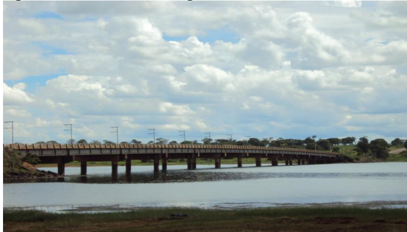
Figura 13 - Ponte sobre o córrego Ribeirão Ponte Pensa
