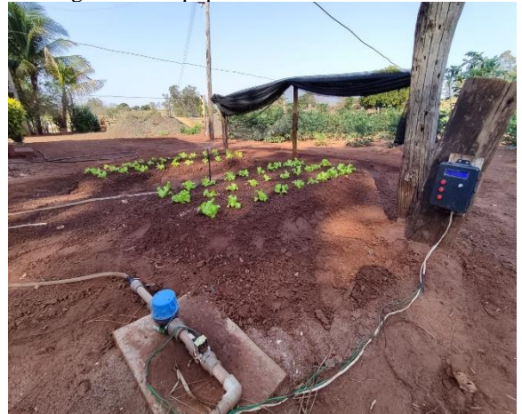
Figura 19 –Equipamento em funcionamento.
