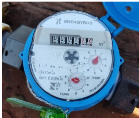
Figura 23 –Hidrômetro utilizado no início da irrigação manual indicando 1120 litros.
