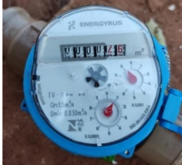
Figura 21 –Hidrômetro utilizado no início da irrigação autônoma indicando 260 litros.
