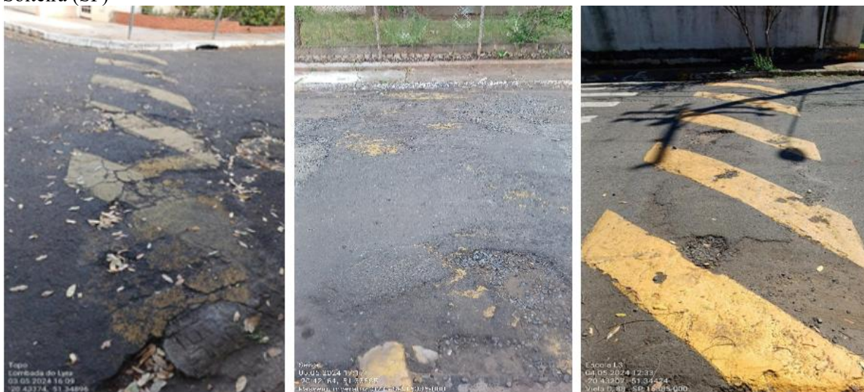
Figura 7 – Exemplos de inconformidades técnicas observadas nas ondulações transversais em Ilha Solteira (SP)
