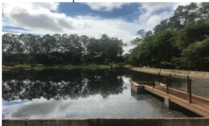
Figura 4 - Estação da lagoa de tratamento de esgoto municipal, situada a 129 metros do canil municipal
